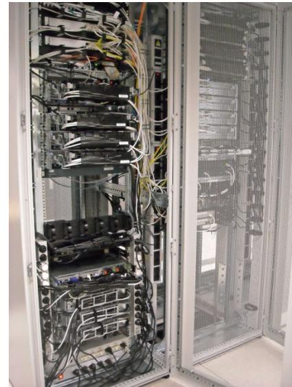
Stesso Cablaggio nel 2010: esempio di cablaggio strutturato dove i cavi sono ben visibili, raggruppati e non ostacolano il circolo dell'aria indispensabile per il raffreddamento.
